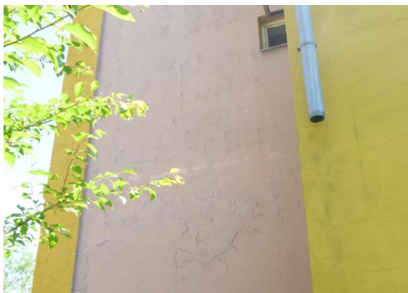
Foto /7/ poškození omítky
