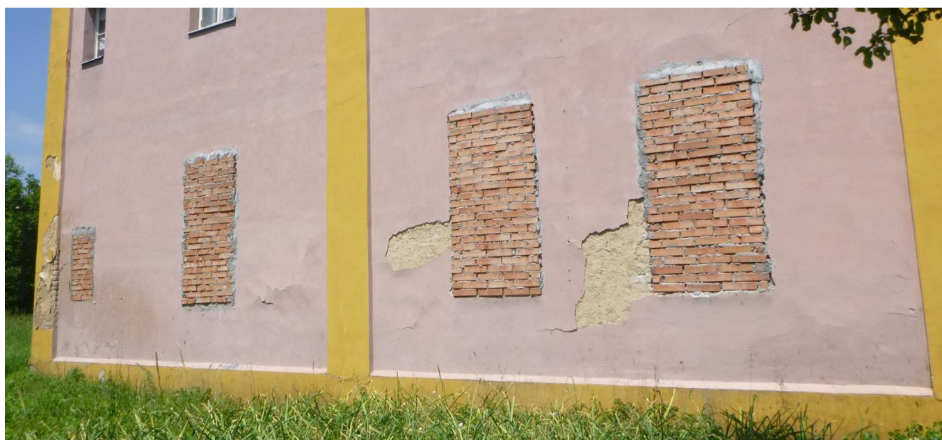
Foto /9/ poškození omítky
