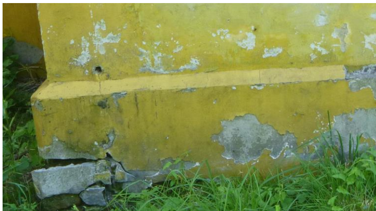
Foto /8/ poškození omítky a soklu
